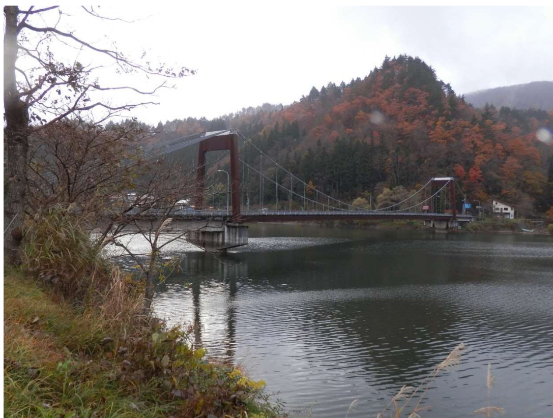
持寄麻生線 麻生大橋
