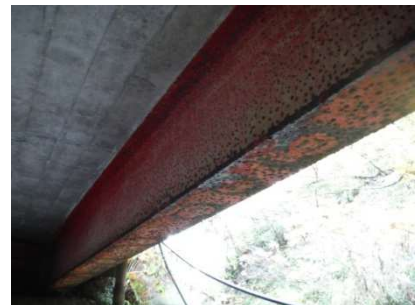
（鋼桁の腐食）
