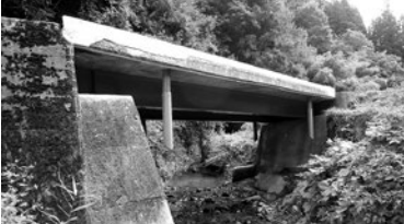
▲橋梁補修工事(道路ストック総点検事業)
