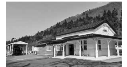
▲会津柳津駅舎(会津柳津駅運営管理事業)
