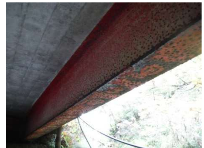
（鋼桁の腐食）
