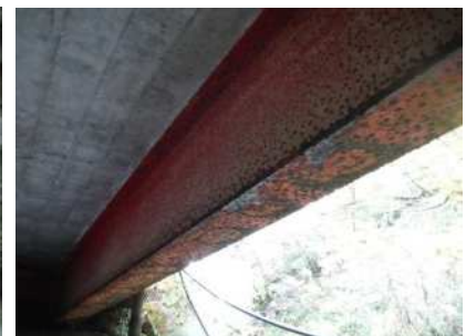
(鋼桁の腐食)
