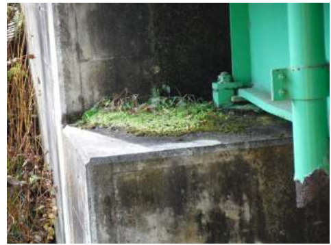
（橋座面における土砂堆積）
