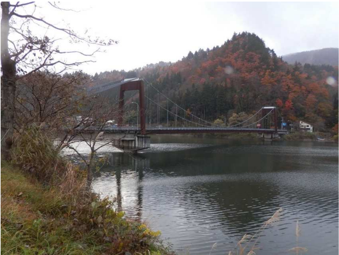
持寄麻生線 麻生大橋
