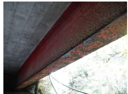
(鋼桁の腐食)
