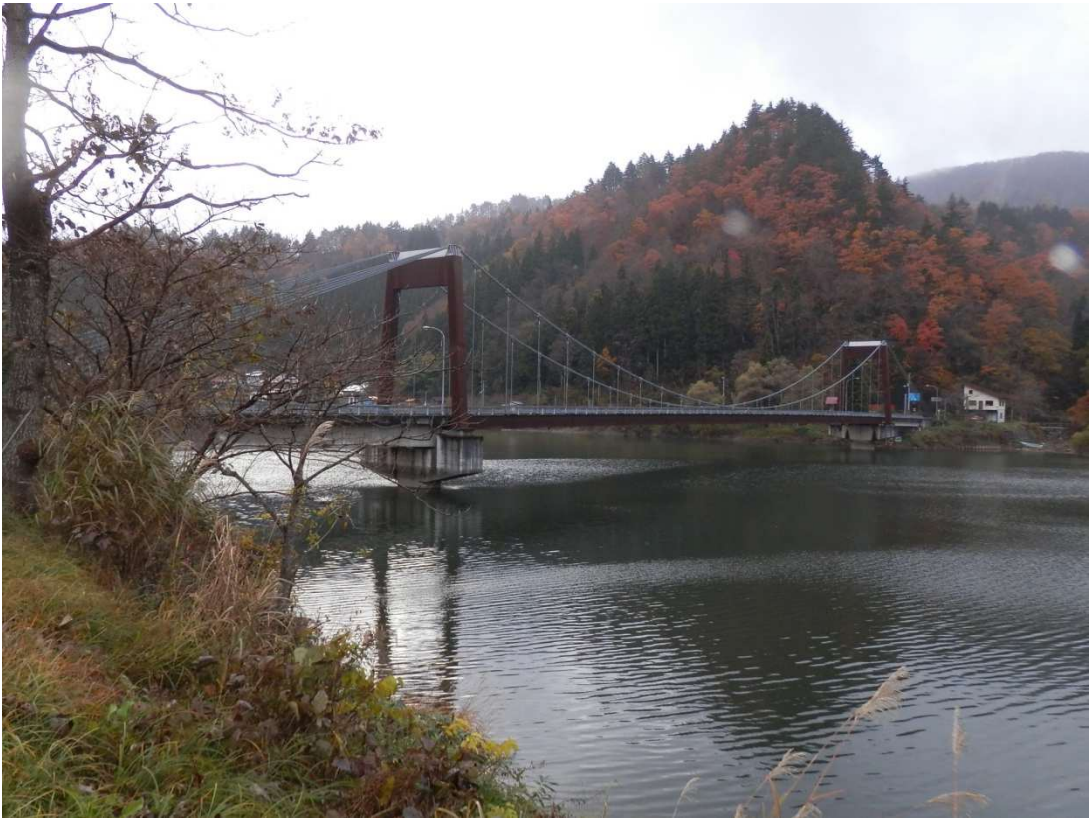
持寄麻生線 麻生大橋
