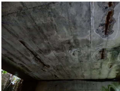
(コンクリート部材の剥離・鉄筋露出)
