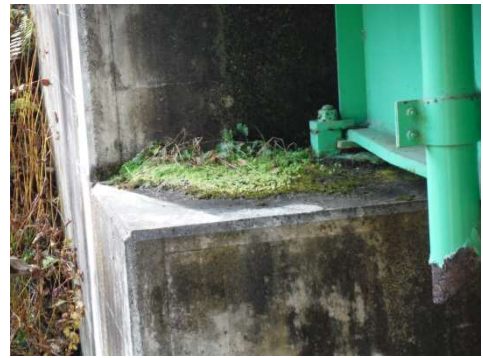
（橋座面における土砂堆積）
