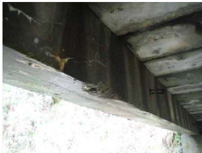
(コンクリート部材の剥離・鉄筋露出)
