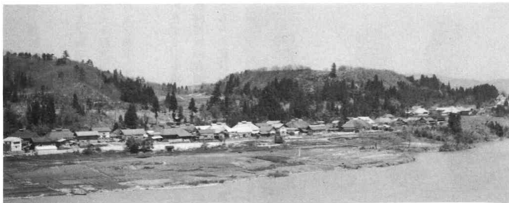
藤部落を望む（遠景は猿戾城址）
