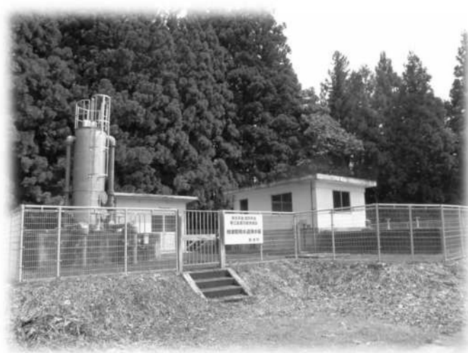
柳津配水池（新村地区）
