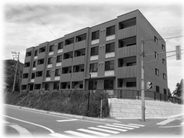
令和2年に完成した柳ヶ丘団地若者定住促進団地
