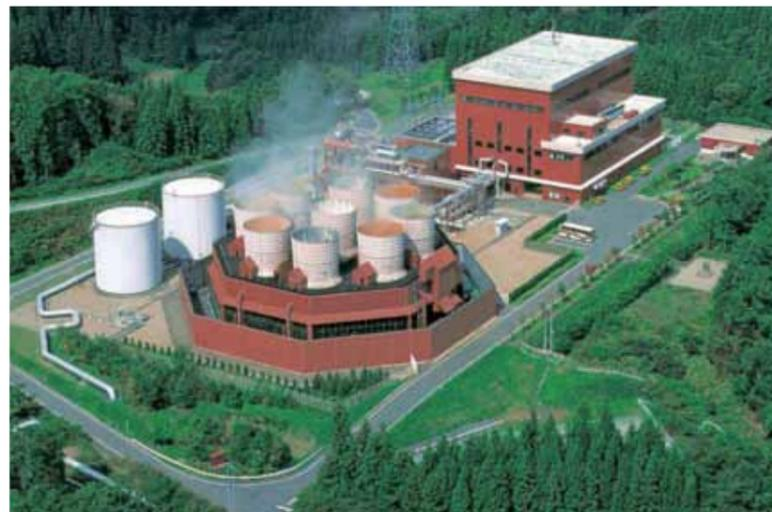
地中深くの熱から発生する蒸気で巨大なタービンを回し、電気を発生させます。日本は火山帯に位置し、地熱発電は戦後早くから注目されてきた発電方法で、東北や九州を中心に展開しています。
