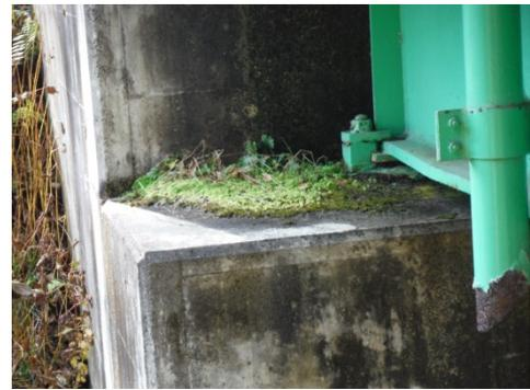
（橋座面における土砂堆積）
