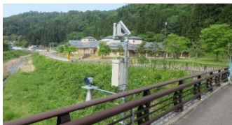
のぞみ橋設置箇所
