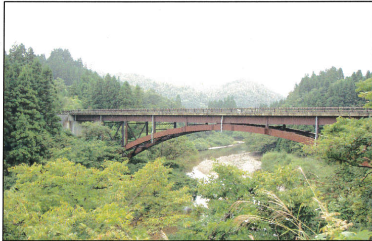
湯谷川に架かる川口大橋
