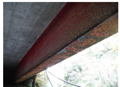
(鋼桁の腐食)
