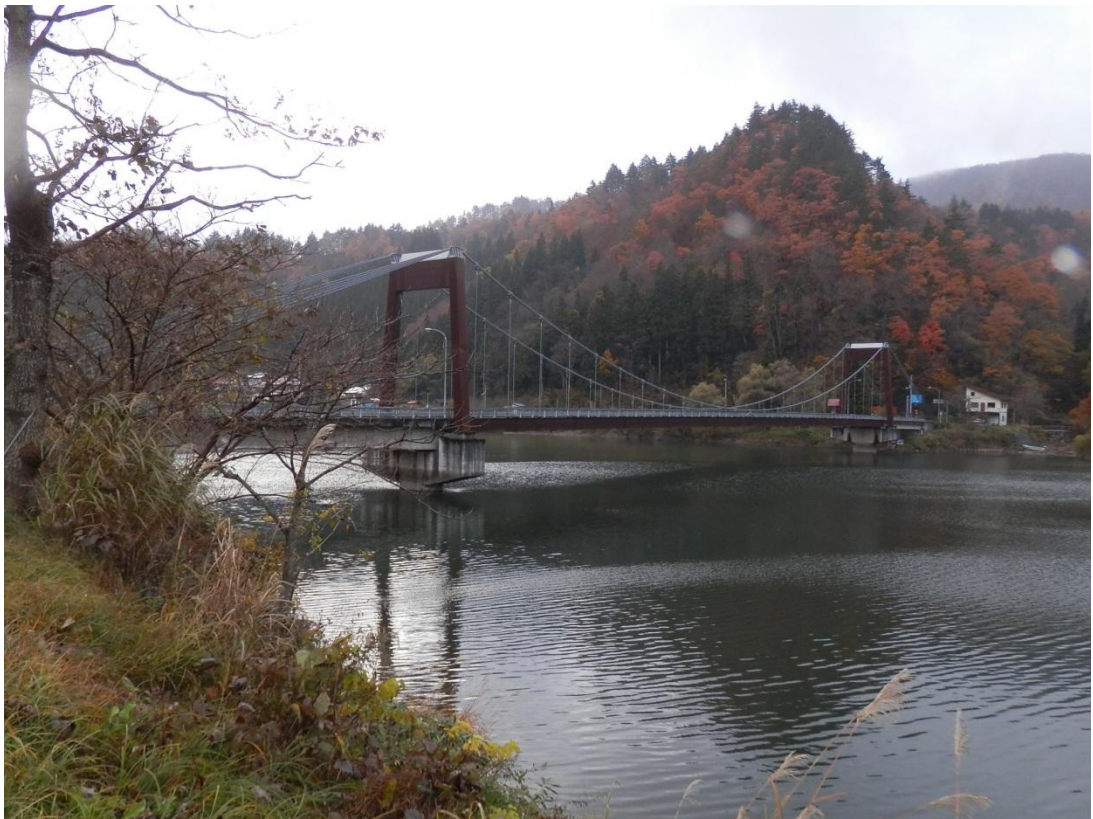
持寄麻生線 麻生大橋
