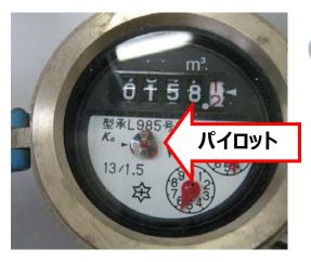
左の図は水道メーターの写真ですが、矢 印で示しているパイロットが宅内で水を使用 していなくても廻っていれば漏水の恐れがあり ます。
