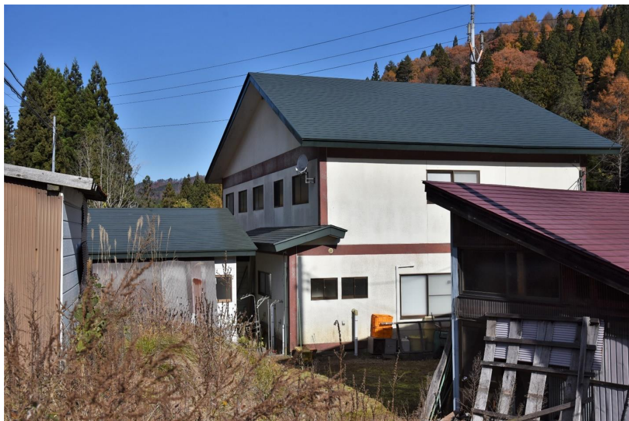
建物南側から。母屋の左側に見えるのが風呂場です。
