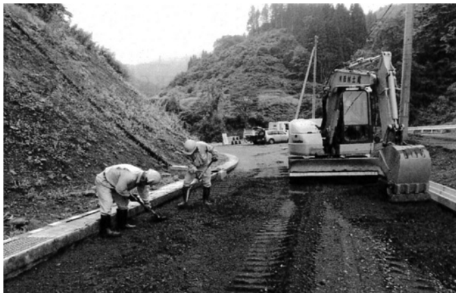
町道五疊敷大成沢線 改良工事の様子
