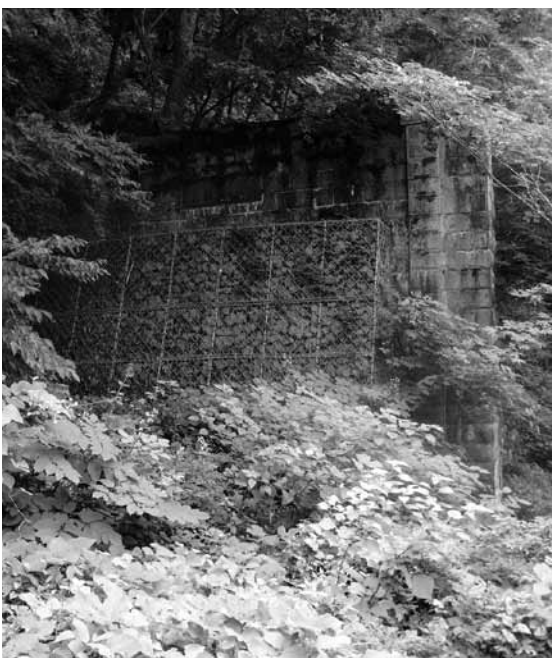
現在の旧松倉トンネル
