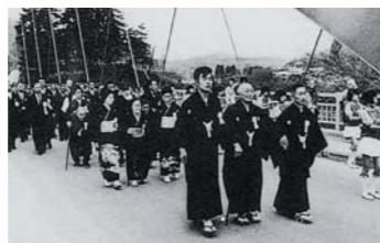
瑞光寺橋が完成し、渡り初めが行われる。(昭和47年)
